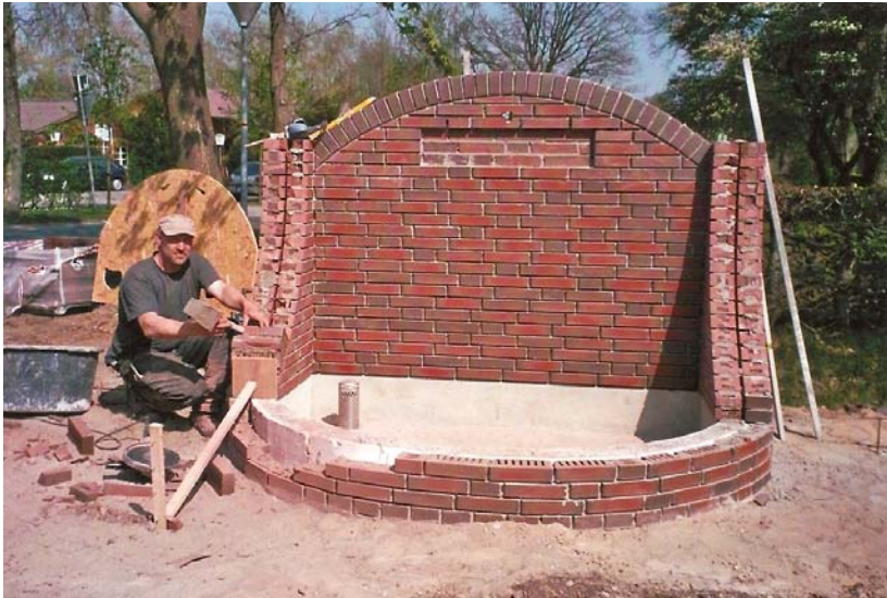
Brunnenbau: auf dem Bild Maurermeister Frank Cordes
